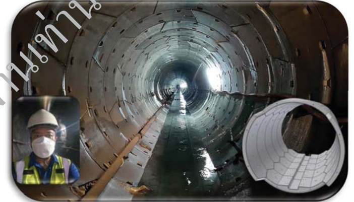
อุโมงค์เมื่อเจาะและติดตั้งแล้วเสร็จ
