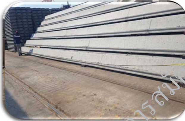
การกองเก็บเสาเข็ม
