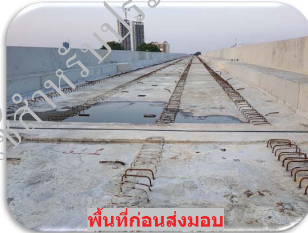
เคลื่อนย้ายเครื่องจักรทำงานด้านบน
