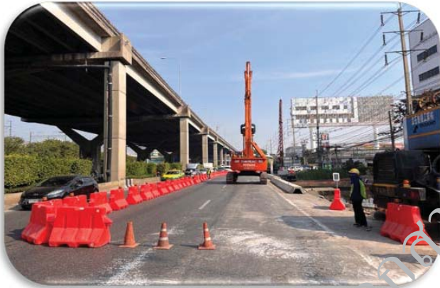
งานเตรียมพื้นที่สำหรับวางเสาเข็ม
