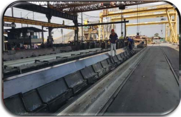
โรงงานผลิตเสาเข็ม
