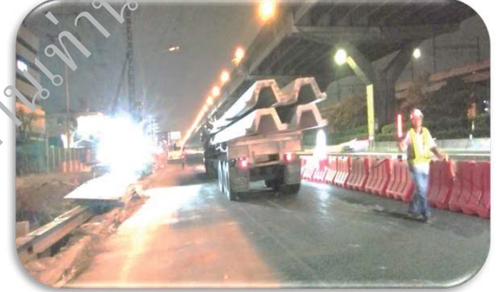
การขนส่งเสาเข็ม
