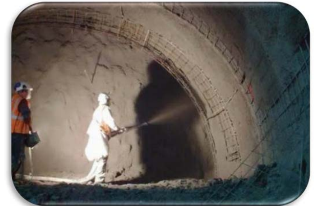
ติดตั้งค้ำยัน
